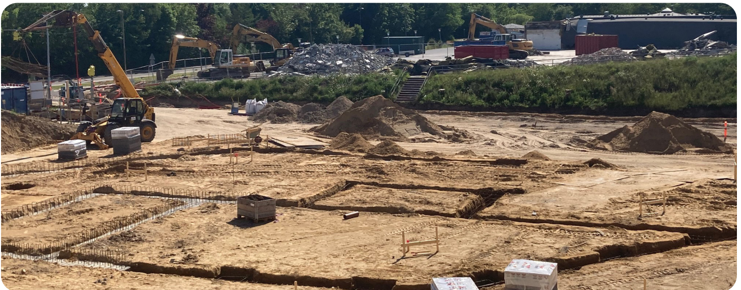
Tryghedsrenoveringen af Afdeling 6 – Bispehaven går fremad og forventes færdig i 2021
